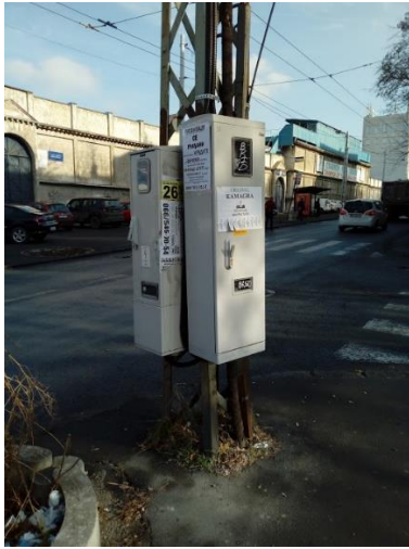
Slika 3 IMO montirani na rešetkasti stub kod stadiona „Obilić“
