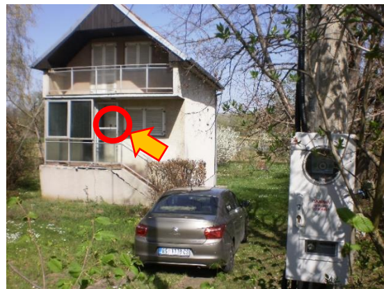
Slika 2 Isti primer, sa vidljivim ranijim MM na fasadi objekta, jednako pristupaćim kao i novo, navodno IMM.
