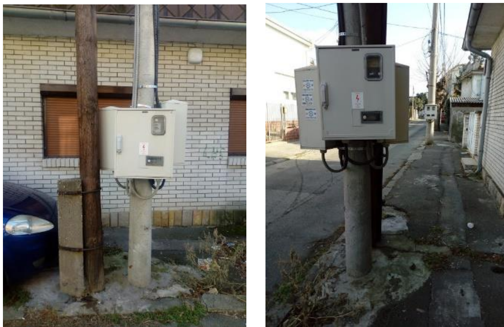
Slika 7 Grupisanje IMO na stablu stuba u ulici Miloša Svilara, Pašino brdo u Beogradu
