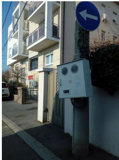
Slika 5 IMO montiran na stablo betonskog stuba u ulici Rada Neimara, na Pašinom (Lekinom) brdu u Beogradu
