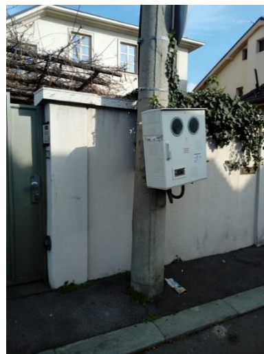
Slika 5 IMO montiran na stablo betonskog stuba u ulici Rada Neimara, na Pašinom (Lekinom) brdu u Beogradu
