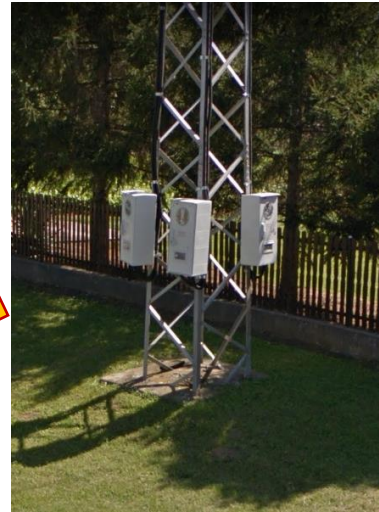
Slika 4 Grupisanje i montaža IMO pod uglom u odnosu na vertikalu, na rešetkastom stubu SN+NN mreže u selu Ratari
