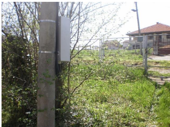
Slika 1 Primer pogrešno lociranog MRO iz sela Provo kod Šapca, montiranog na stub NN mreže trasirane kroz privatne posede.
