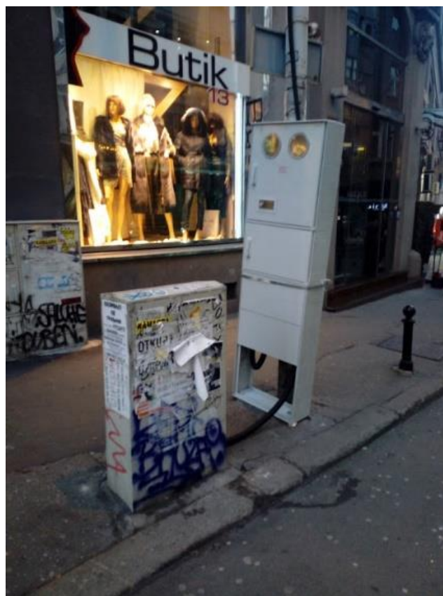
Slika 10 Primer kombinovanog nepoštovanja odredbi TP 13a u Sremskoj ulici, u centru Beograda
